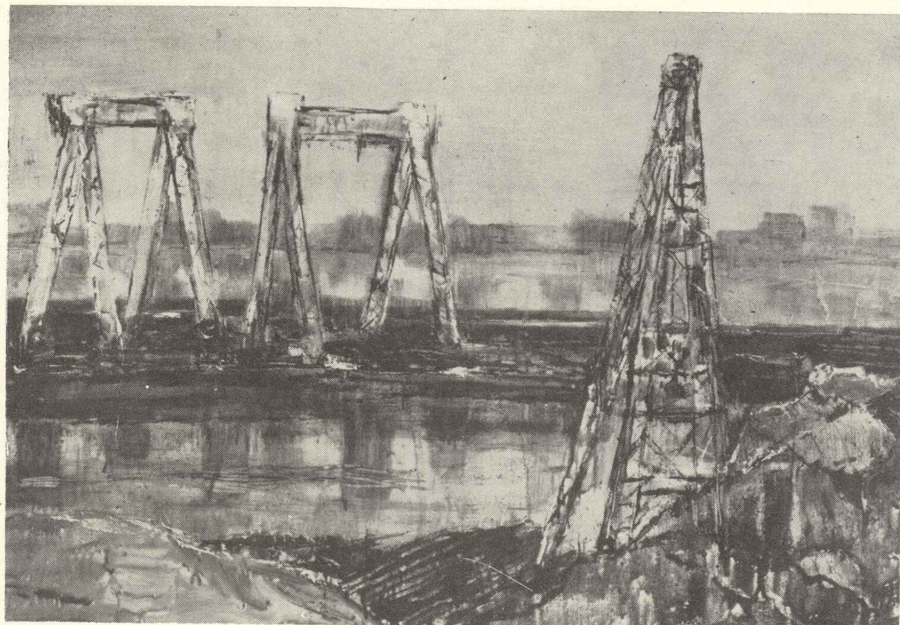
Budowa Mostu Toruńskiego I, 1980
