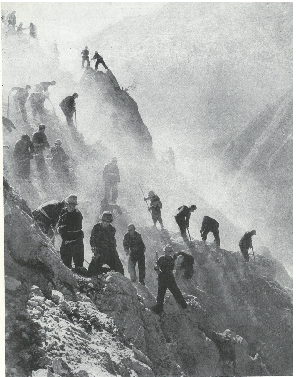
Tędy popłynie rzeka Taoho Inducting the Taoho river water up the mountain
